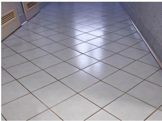
Slika 3: Tla, obložena s keramičnimi ploščicami v sanitarijah v 1. nadstropju
