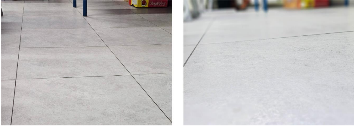
Slika 5: Tla, obložena s ploščami iz granitogresa v pritličju
