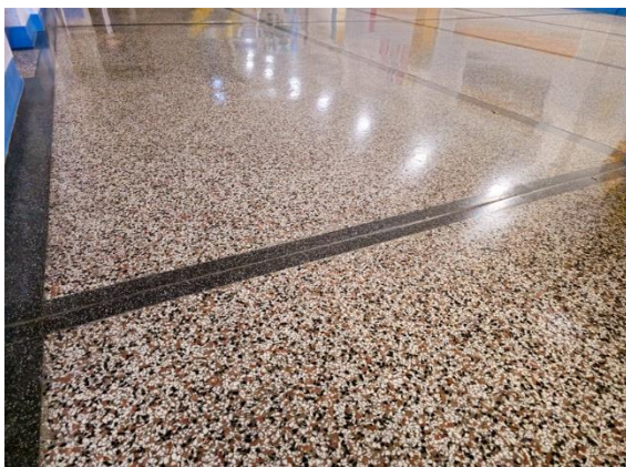
Slika 1: Tla iz poliranega betona v avli v 2. nadstropju
