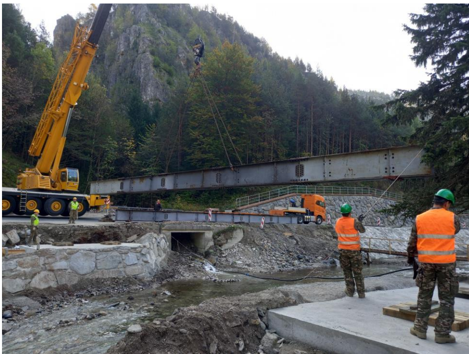
Slika 26 Izdelava montažnega mostu
