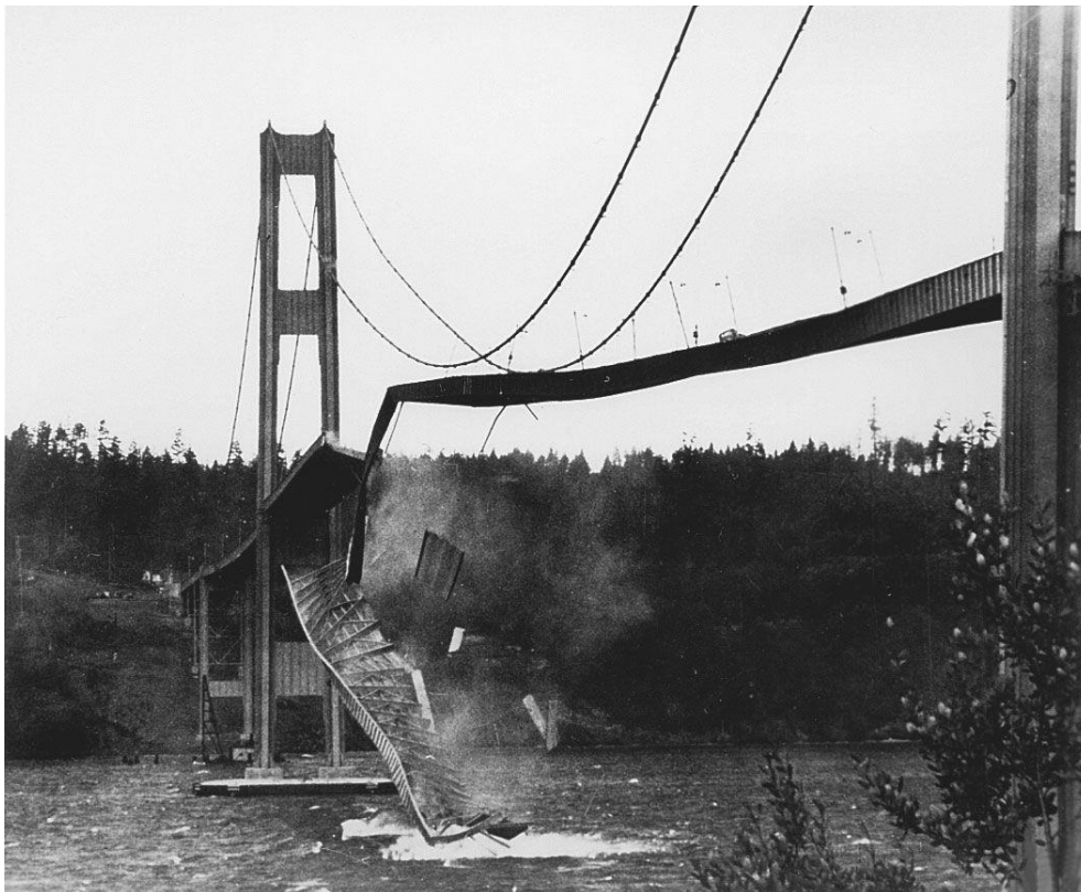
Slika 13 Porušitev zaradi nihanja konstrukcije, Tacoma bridge 1940
