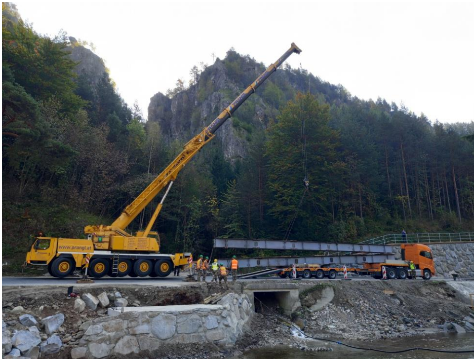
Slika 25 Izdelava montažnega mostu
