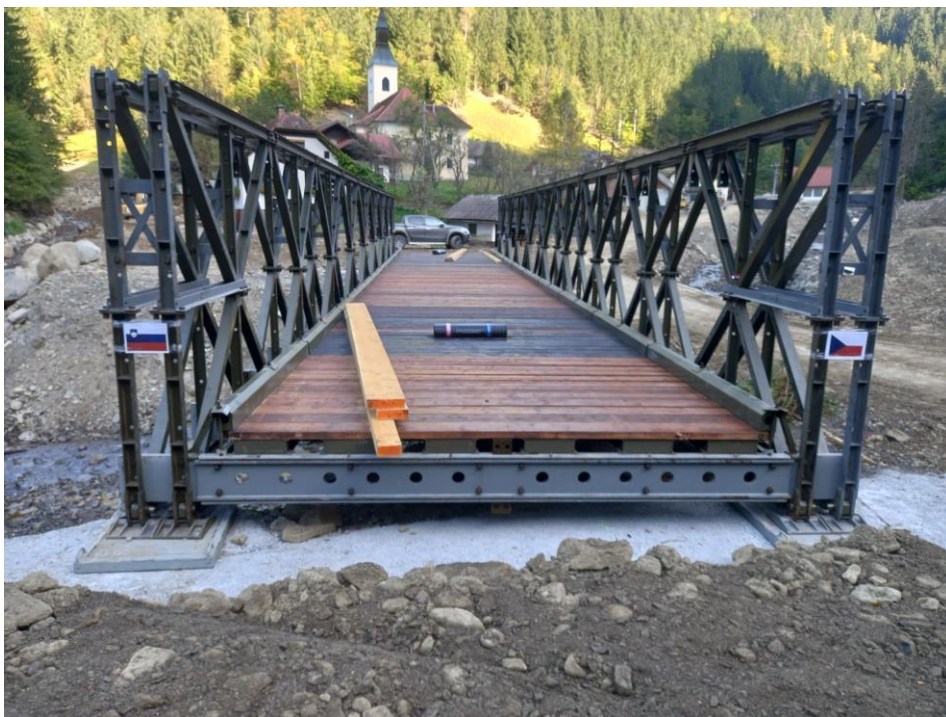
Slika 28 Izdelava montažnega mostu
