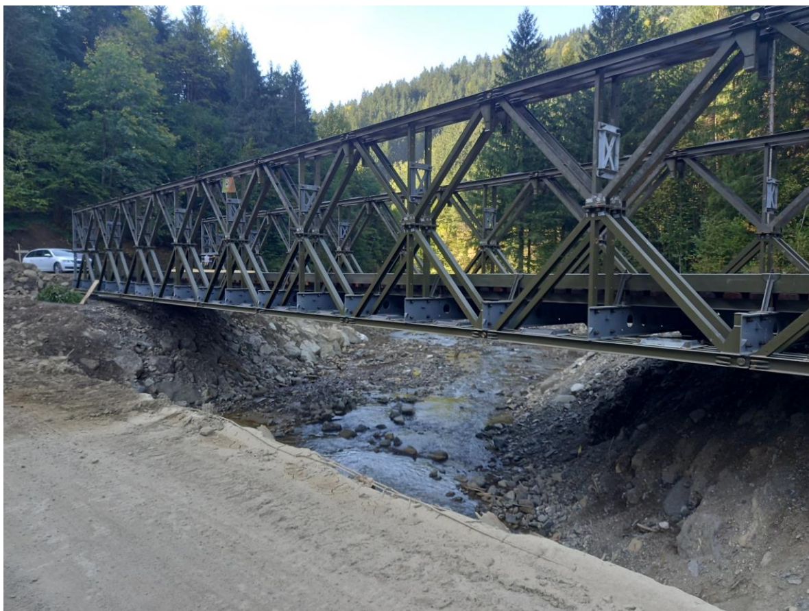
Slika 20 Montažni most Ljubno (Rastke)
