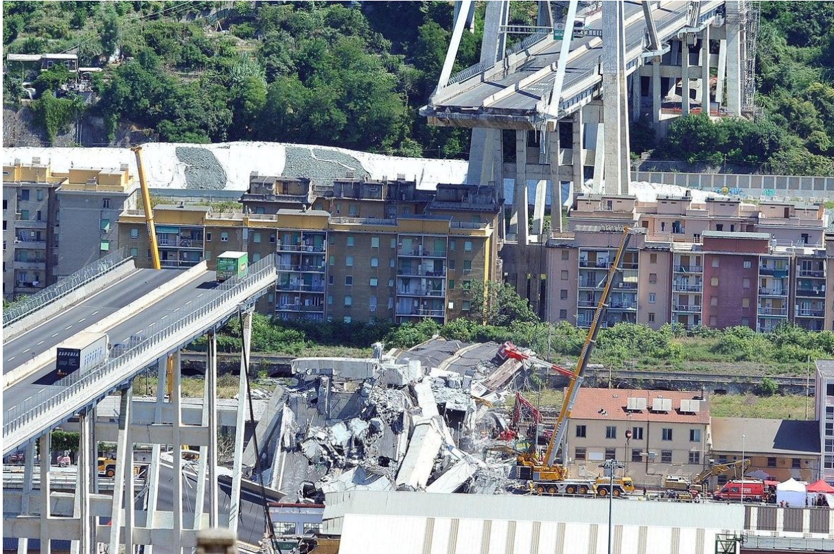
Slika 17 Porušitev mostu Morandi, Italija
