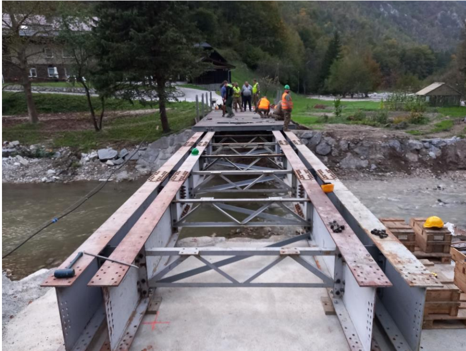
Slika 27 Izdelava montažnega mostu
